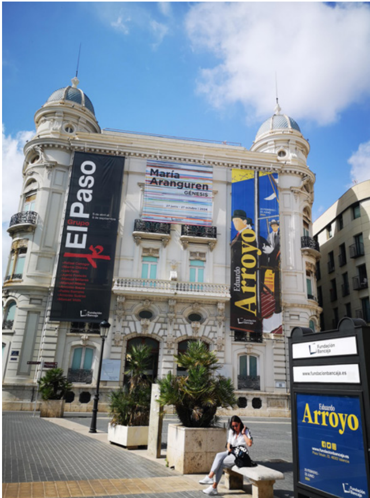
Edificio Fundación Bancaja (Valencia)
